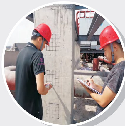
回弹法检测混凝土强度
