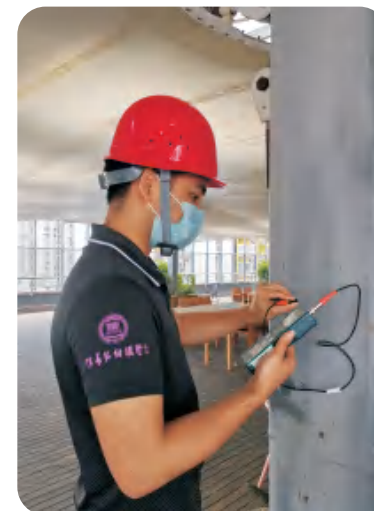
钢结构涂层厚度检测
