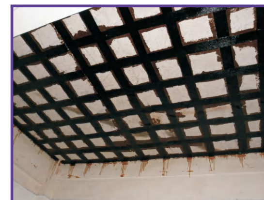
粘贴碳纤维加固混凝土楼板
