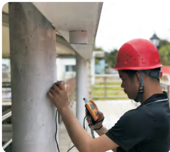
超声波检测钢结构材料厚度
