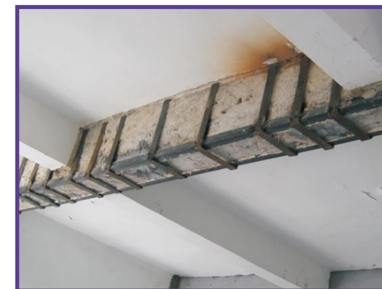
包钢法加固混凝土梁
