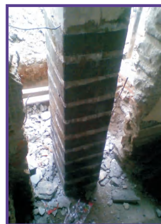
粘贴碳纤维法加固混凝土柱
