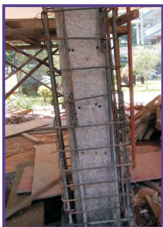
加大截面法加固混凝土柱
