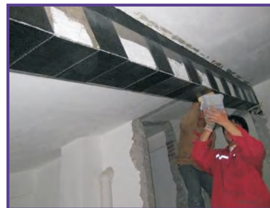
粘贴碳纤维法加固混凝土梁
