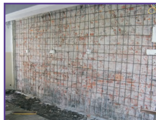
混凝土夹板墙改变单跨框架结构体系
