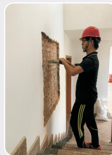
贯入法检测砂浆强度
