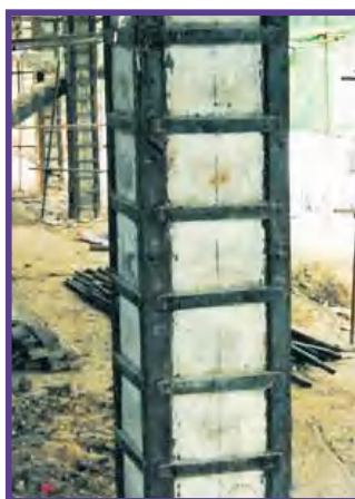
包钢法加固混凝土柱
